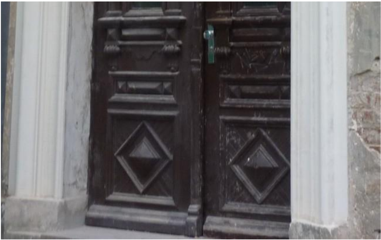
Rekonstrukcja portalu. Boczne elementy zostały wykonane metodą ciagnioną (tradycyjną). Zdjęcia ukazują portal przed malowaniem.
